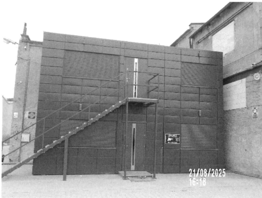
Przykładowy kontener biurowy
